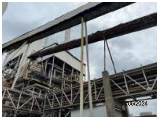
รูปที่ 2-10 การขนส่งเปลือกไม้ทางสายพาน เข้าสู่ Power Boiler
